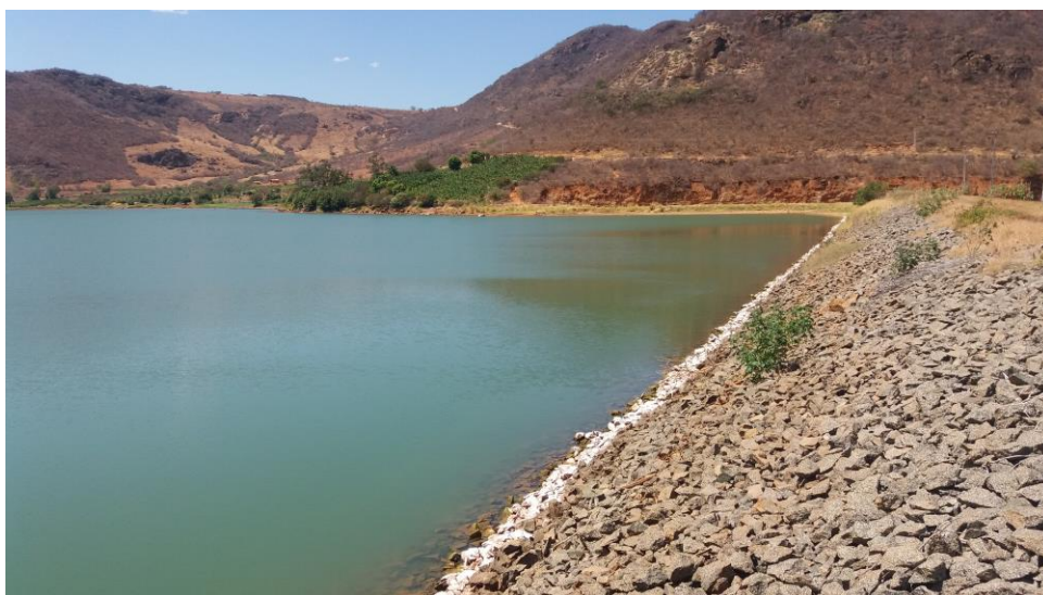
Figura 6 - Captação Ceraíma. EMBASA 2018.
